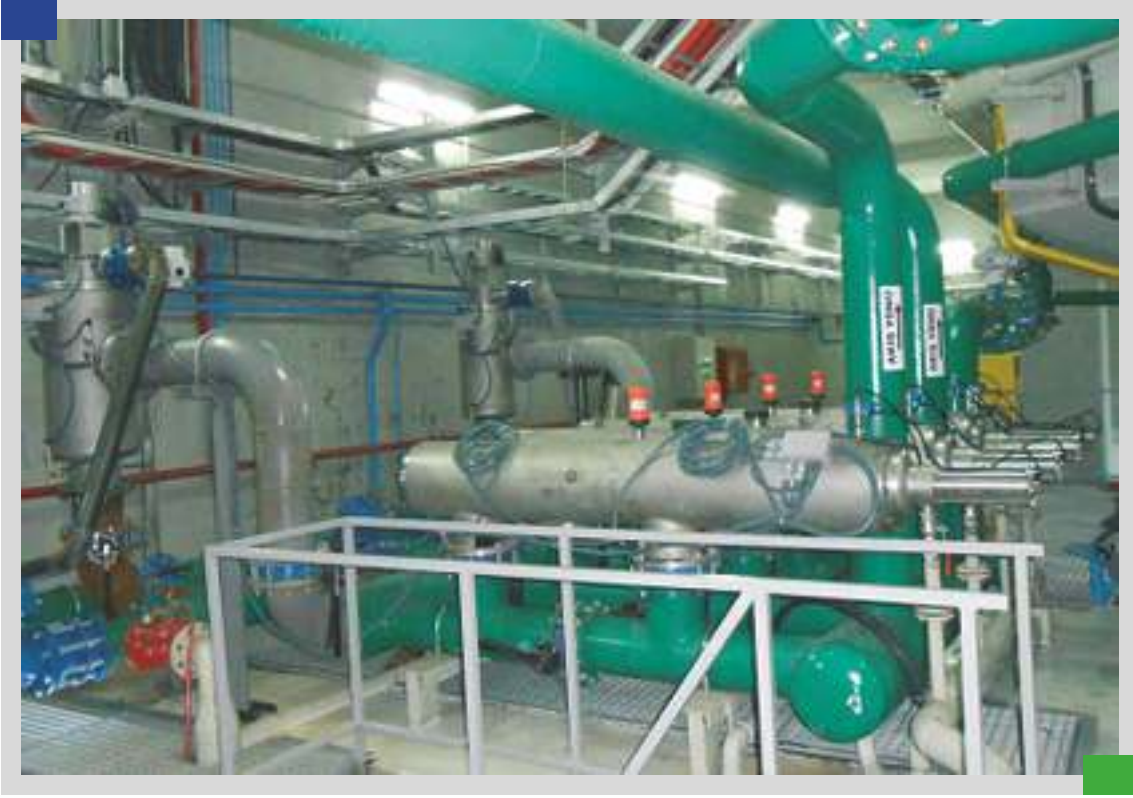
Burçak 1 Hidroelektrik Santrali (Giresun, Şebinkarahisar)
