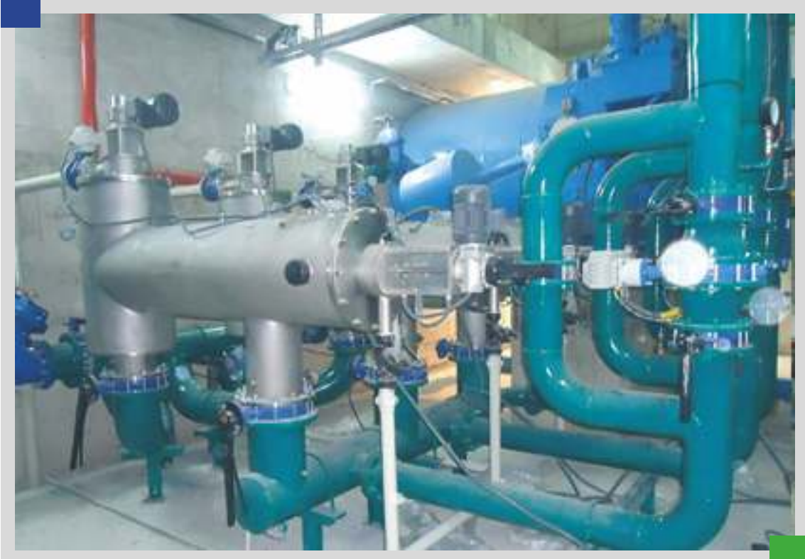
Burçak 2 Hidroelektrik Santrali (Giresun, Şebinkarahisar)
