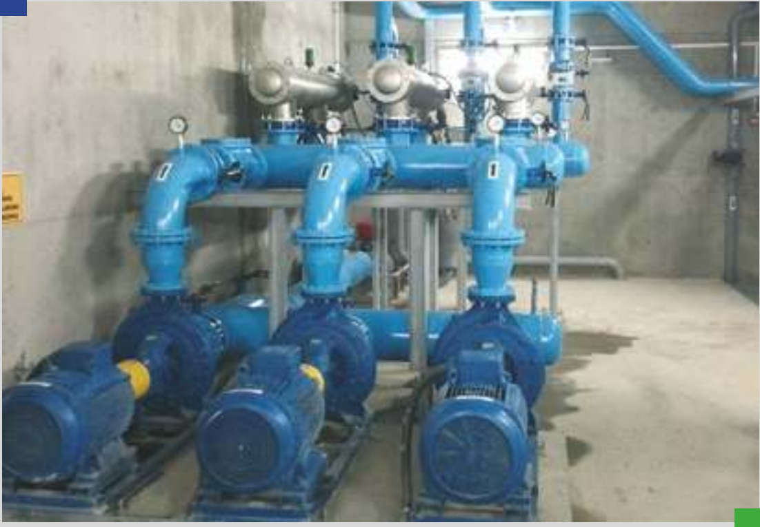
Doğankaya Hidroelektrik Santrali (Adıyaman)
